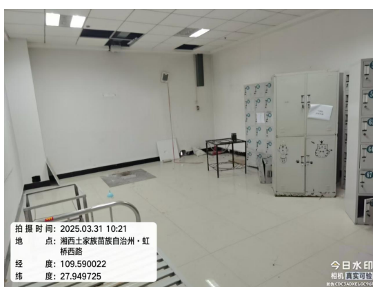
放射一室（DR 机房）内部
