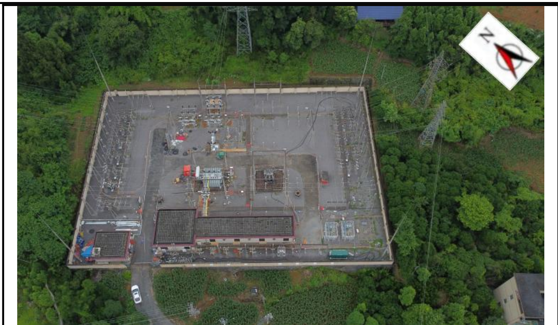
图 3-1 官地坪 110kV 变电站周围环境现状
