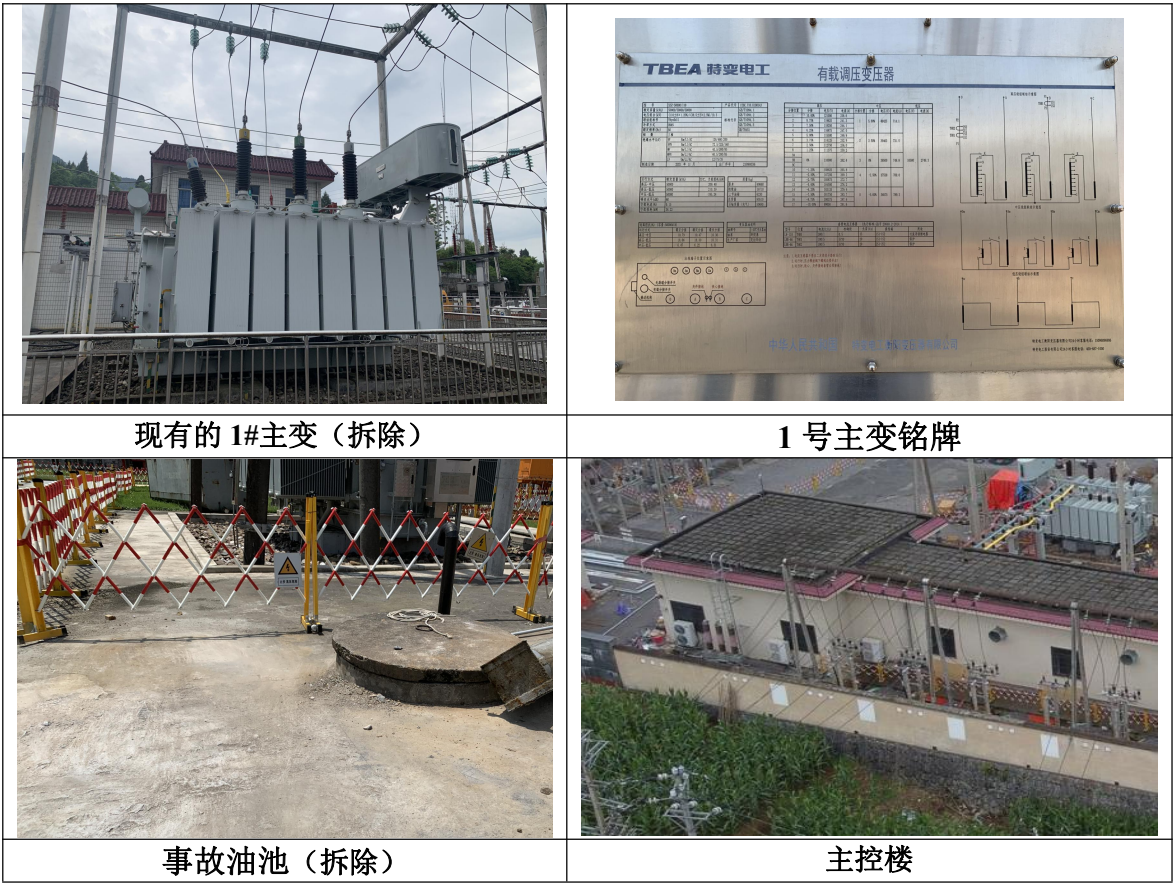
图 2-1 变电站站内环境现状
