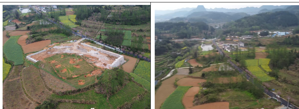
拟建变电站站址周边环境现状
