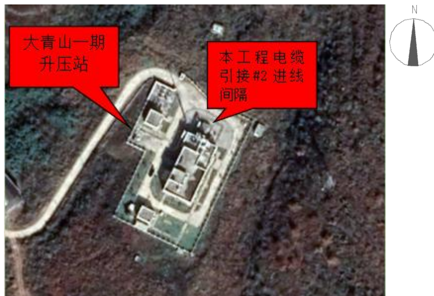
图 2-1 大青山一期升压站
