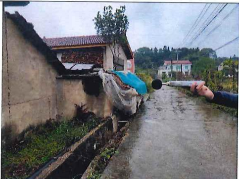
常德市桃源县漳江街道办事处金雁村六组 (2) 民房 b 东南侧 (E: 111°23'33.93", N: 28°55'58.08")
