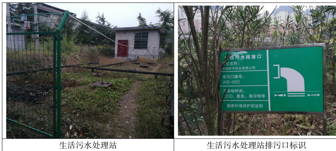
图 3.2-1 钟灵山生活污水处理站现状情况
