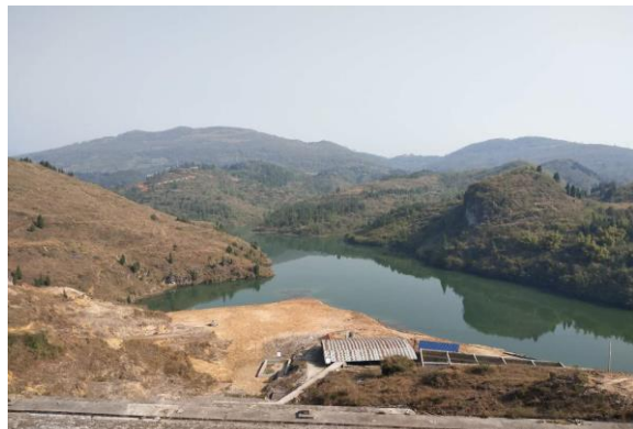
渗滤液收集池
